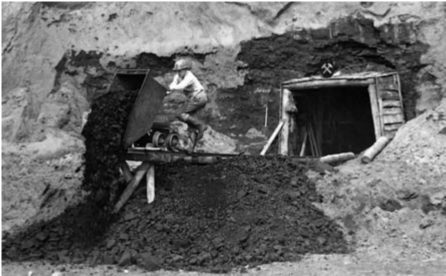
Abb. 302: Beginn des Restpfeilerabbaus Treue im Tiefbau, Mai 1962. Der Ausbruch vom Stollenvortrieb wird mit kleinen Hunten nach über Tage gebracht. Die Stirnseiten-Kastenkipper werden dabei von Hand geschoben. Der Versuchstiefbau soll Erkenntnisse bringen zu einer möglichen Gewinnung der unteren Flöze. Anfangs, in Zeiten der Hochkonjunktur, ist auch die Kohle aus der zusätzlichen Gewinnstätte sehr willkommen.
