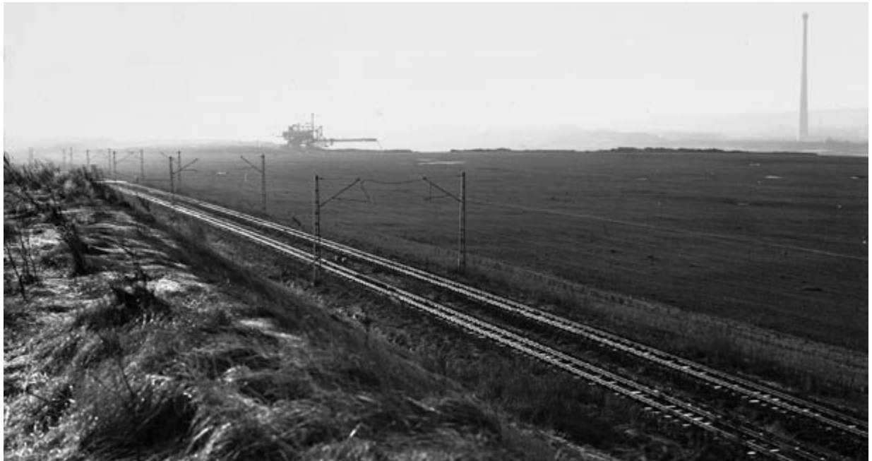
Abb. 410: Die Aufnahme vom 27. November 1980 zeigt die zweigleisige Strecke vom Tagebau Helmstedt zur Verladung und zu den Hauptwerkstätten. Mit dem guten Oberbau und der Fahrleitung ist sie einer regelspurigen Hauptbahn sehr ähnlich. Hinten ein Absetzer beim Verkippen des Tagebaues Treue und rechts der fast fertiggestellte 300 m hohe Kamin des Kraftwerkes Buschhaus.
