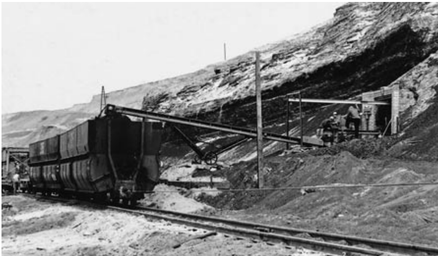
Abb. 303: Über Förderbänder gelangt die Tiefbau-Kohle unweit der Mundlöcher in Wagen der Grubenbahn. Rangiert werden diese an der Verladestelle offensichtlich mittels Seilzug.
