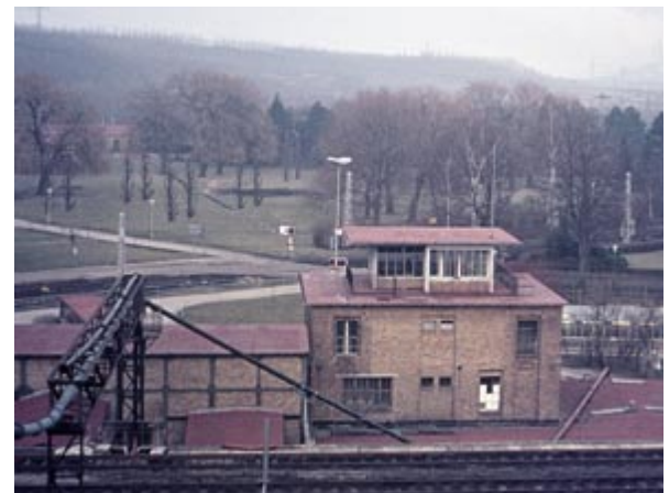
Abb. 412: Stellwerk K5 befindet sich gleich neben der Aufbereitung Büddenstedt zwischen den Werksbahngleisen. An dieser Stelle trat früher die Kettenbahn aus dem Tagebau Treue zutage; hier war die Antriebsstation. Als das Stellwerk nicht mehr gebraucht wird, zieht in die Glaskanzel mit ihrem guten Überblick der Werkschutz ein.
