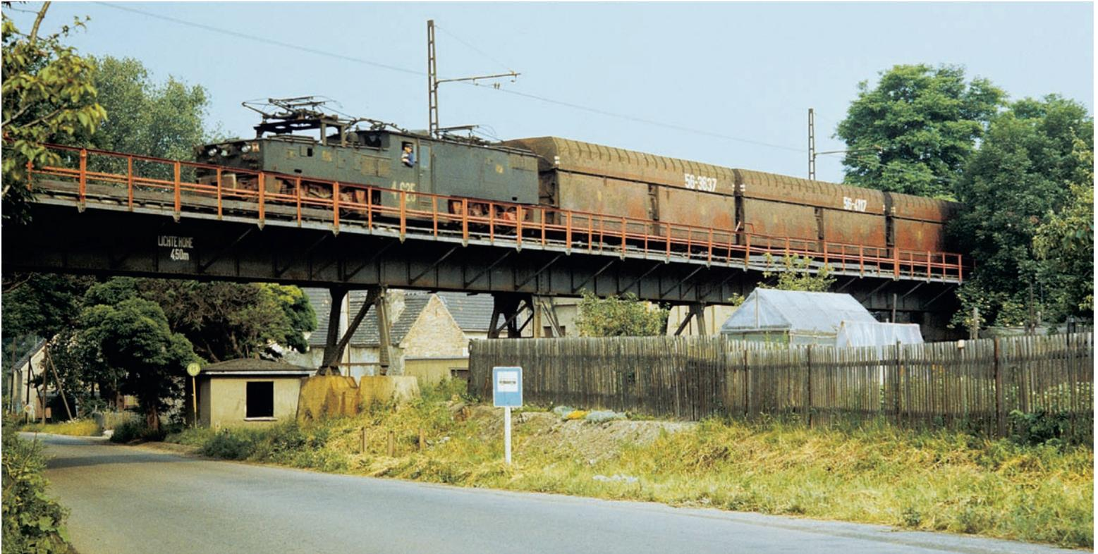
Auf der Hohenmölsener Brücke: Lok 4-625, noch abgebügelt wegen eben passierter Schutzstrecke, am geschobenen Vollzug; der Lokführer schaut nach hinten auf die Strecke.
