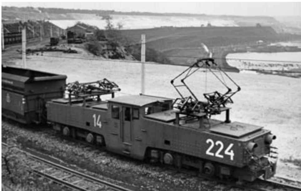
Und: Die Rheinische Braunkohle hat noch mehr Bedarf! Bis 1950 werden in zwei Bauserien noch 17 weitere Abraumloks für die RAG gebaut, mit einigem Abstand kommen 1959/60 nochmal vier Maschinen mit verstärkten Zug- und Stoßvorrichtungen dazu.
